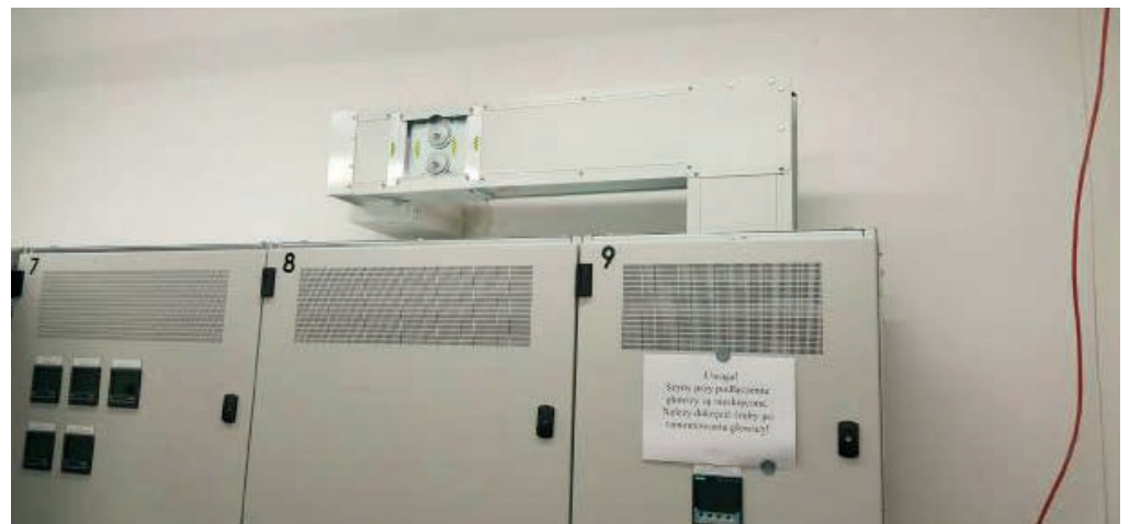
Głowica do transformatora szynoprzewodu POWERTECH 2000A [Electropoli, Nowa Sól], fot. ZPUE
