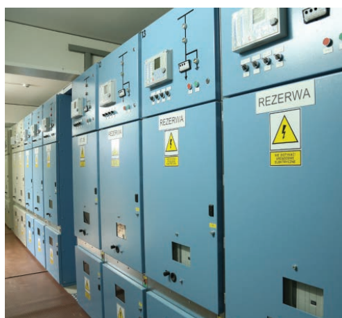
Dwie dwuczłonowe, przedziałowe rozdzielnice SN typu RELF zasilają nowy terminal w Pyrzowicach
