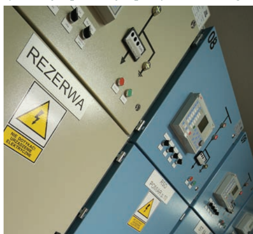
Dwie dwuczłonowe, przedziałowe rozdzielnice SN typu RELF zasilają nowy terminal w Pyrzowicach
