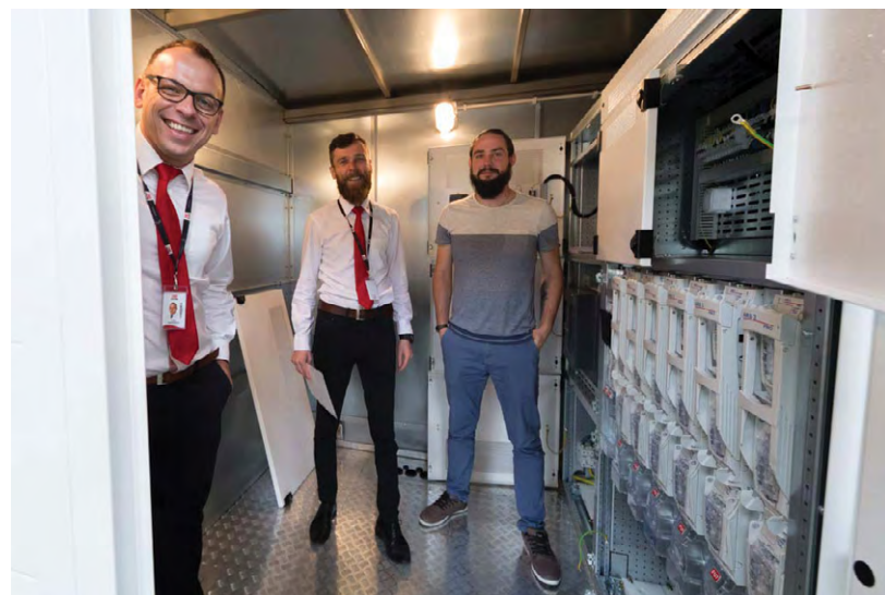
PRZED WYSŁKĄ STACJE PRZESZŁY SZCZEGÓŁOWE TESTY FAT W OBECNOŚCI NASZYCH CZESKICH PARTNERÓW.
