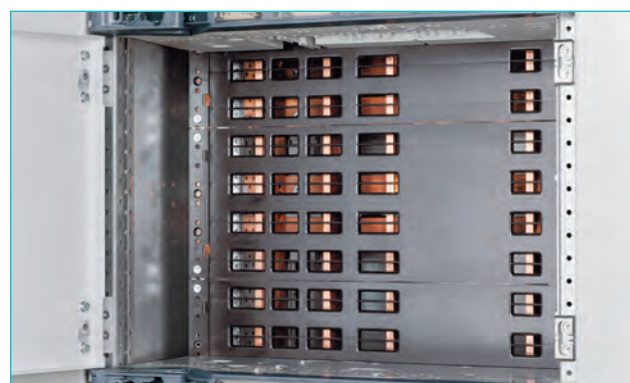
System szyn dystrybucyjnych, zabezpieczony przed przypadkowym dotknięciem (IP20B)
