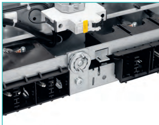
Element kodujący w jednostce wysuwnej
