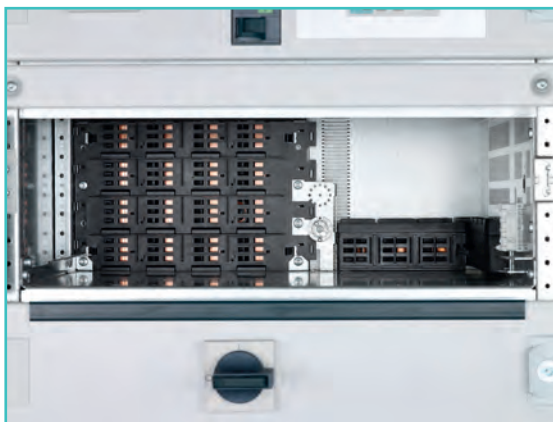
System szyn wtykowych w tylnej części przedziału
