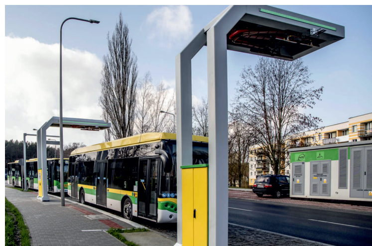
Stacja ładowania autobusów w Zielonej Górze. Bus charging station in Zielona Góra, Poland.
