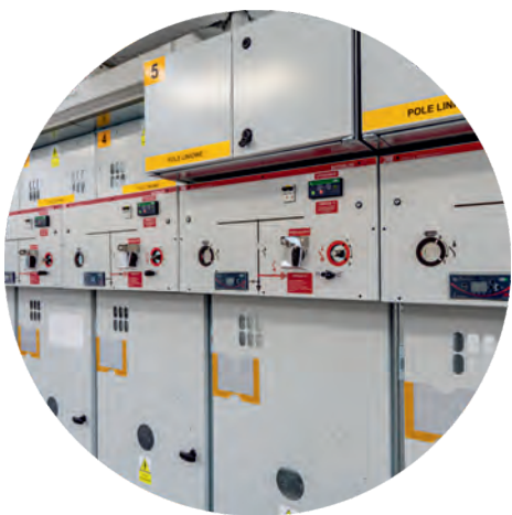
Pola rozdzielnic modularnej typu ROTOBLOK ROTOBLOK type modular switchgear bays.
