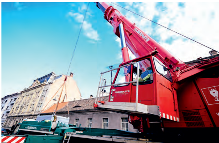
Podziemna stacja transformatorowa w historycznej części Sybina w Rumunii. An underground transformer station in the historic part of Sibiu, Romania.
