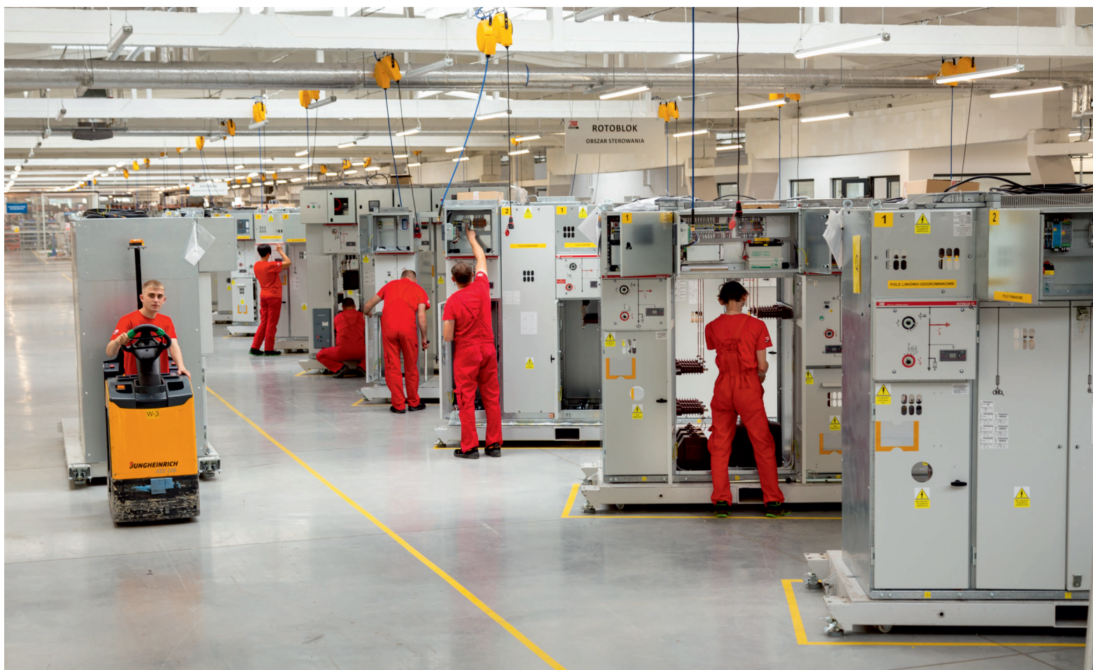
Hale produkcyjne w Zakładzie we Włoszczowie / The production halls at the plant in Włoszczowa
