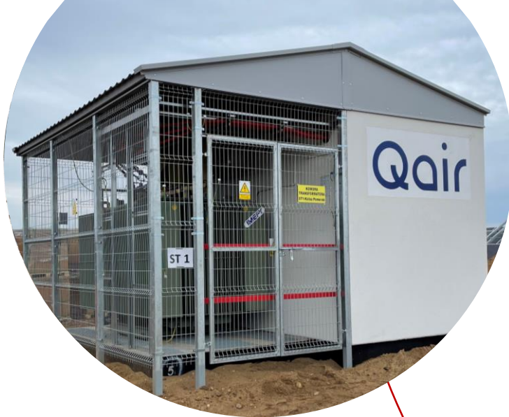
Stacje wielkomocowe dla farmy fotowoltaicznej w Karnowie.
