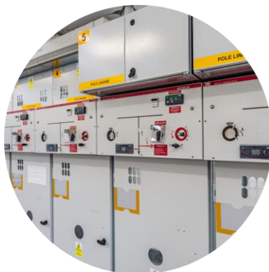
Pola rozdzielnic ROTOBLOK VCB.
