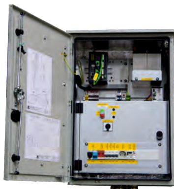
Szafa obiektowa S0-5-THO-T1 ze sterownikiem Ex-micro_xx
