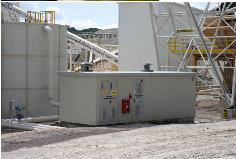
Wentylacja wymuszona, układ z filtrami
