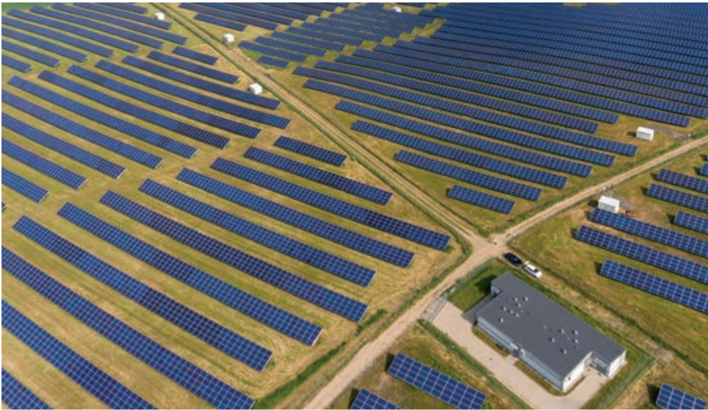
72 stacje o mocy 1 MW wyposażone w rozdzielnice SN oraz nN produkcji ZPUE
