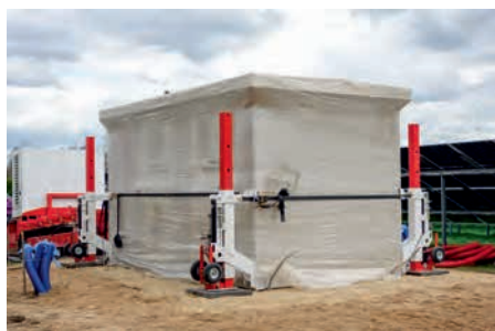
Stacja już na ziemi
