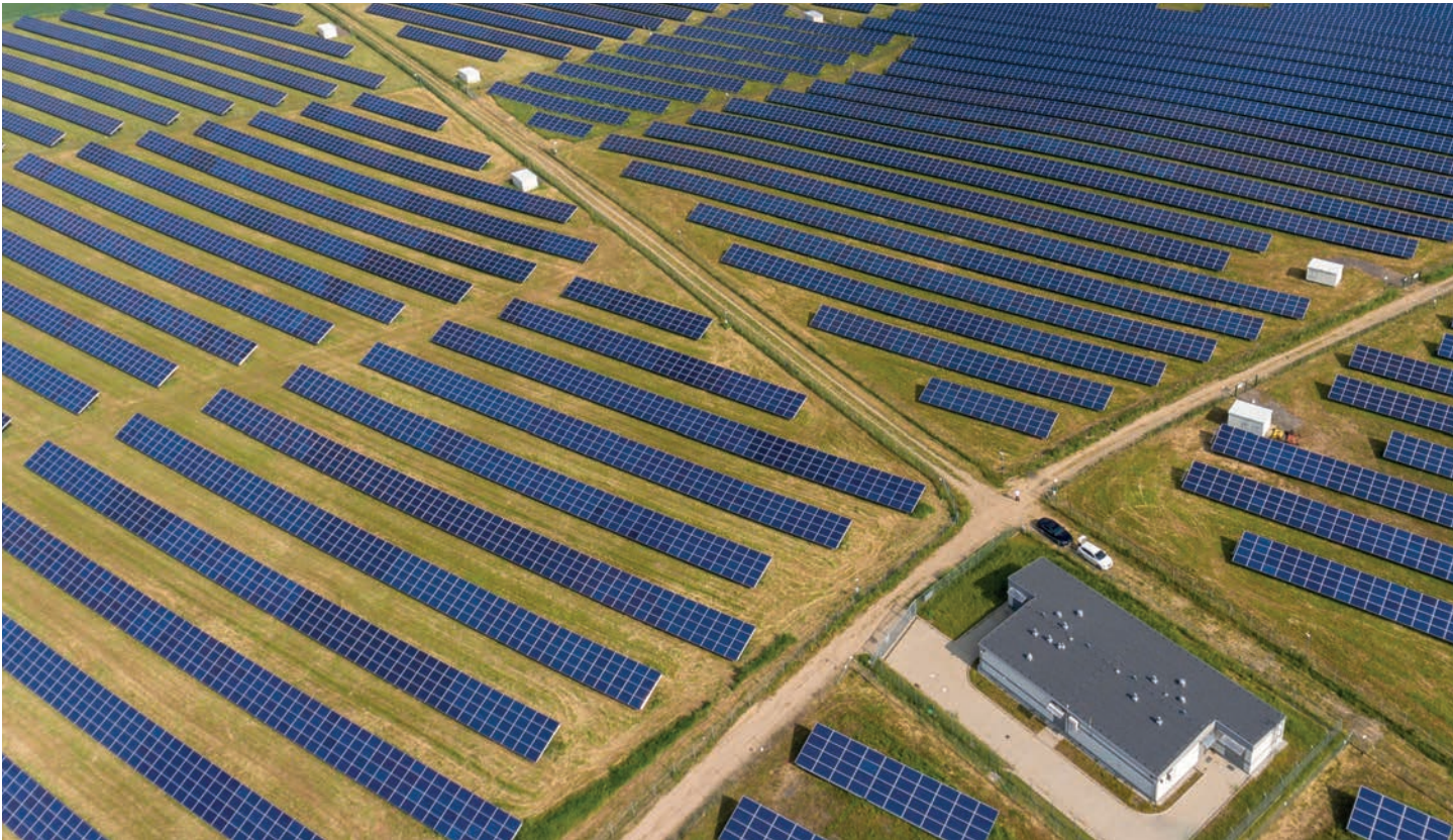
72 stacje o mocy 1 MW wyposażone w rozdzielnice SN oraz nN produkcji ZPUE S.A.
