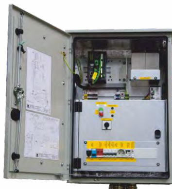
Szafa obiektowa S0-5-THO-T1 ze sterownikiem Ex-micro_xx
