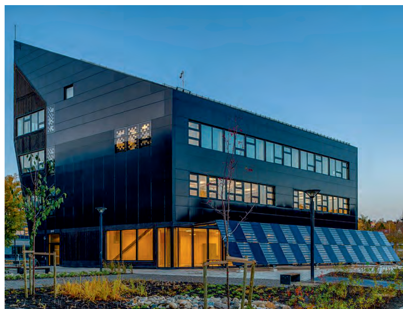
Budynek laboratorium NTNU/SINTEF w Trondheim, w którym został zbudowany magazyn energii na wosk
