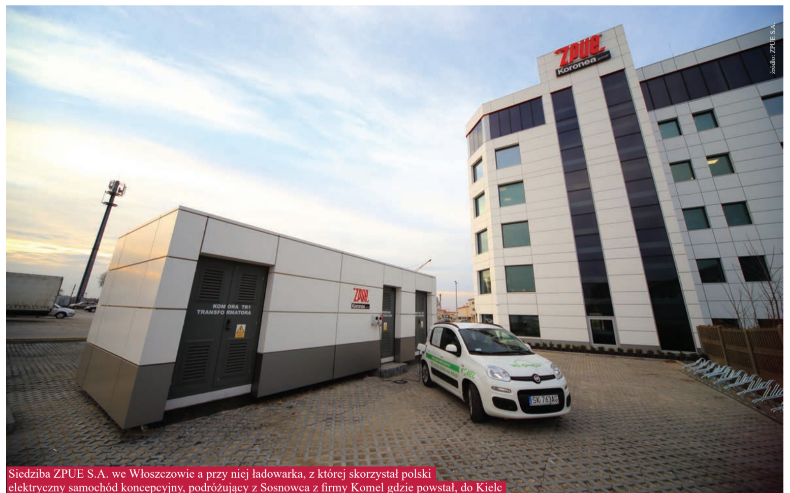
Kontenerowa stacja transformatorowa wyprodukowana przez ZPUE zasila ładowarki taksówek, obsługujących klientów lotniska Schiphol w Amsterdamie
