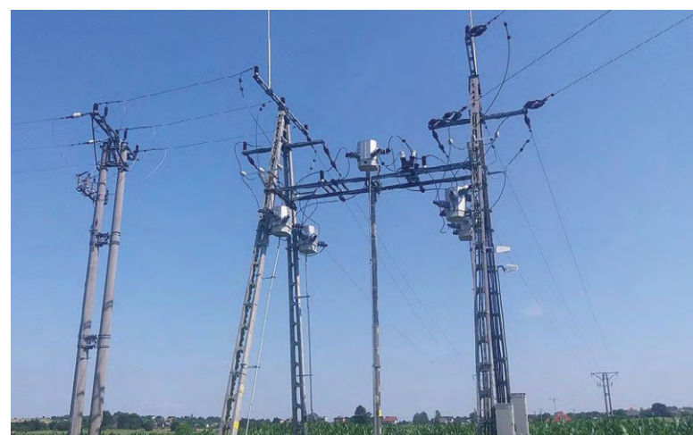
REALIZACJA PUNKTU ROZŁĄCZNIKOWO-REKLOZEROWEGO W RAMACH AUTOMATYZACJI SIECI NA TERENIE PGE SKARŻYSKO-KAMIENNA.
