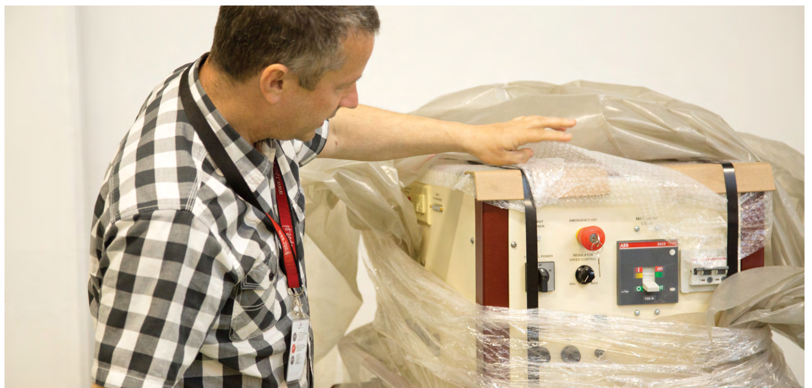
ZAAWANSOWANE URZĄDZENIA SĄ W TRAKCIE MONTAŻU. NA ZDJĘCIU ROBERT WOJCIECHOWSKI, KIEROWNIK NOWO POWSTAJĄCEGO CENTRUM.
